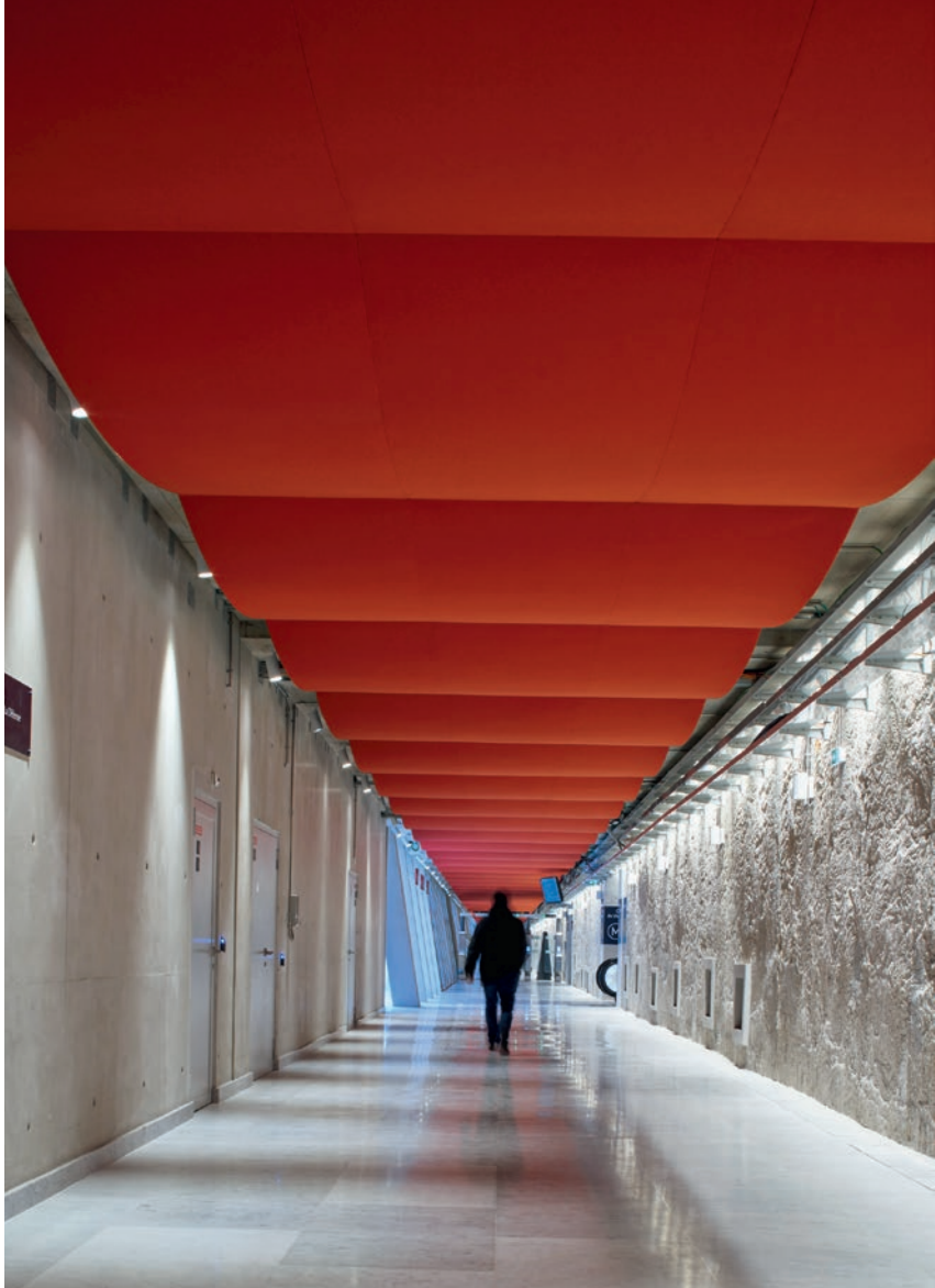
Akustikverkleidung Vibrasto als wellenförmige Deckenstruktur. Bahnhof RER E Neuilly Porte Maillot (Paris). Architekt : JM Duthilleul.
