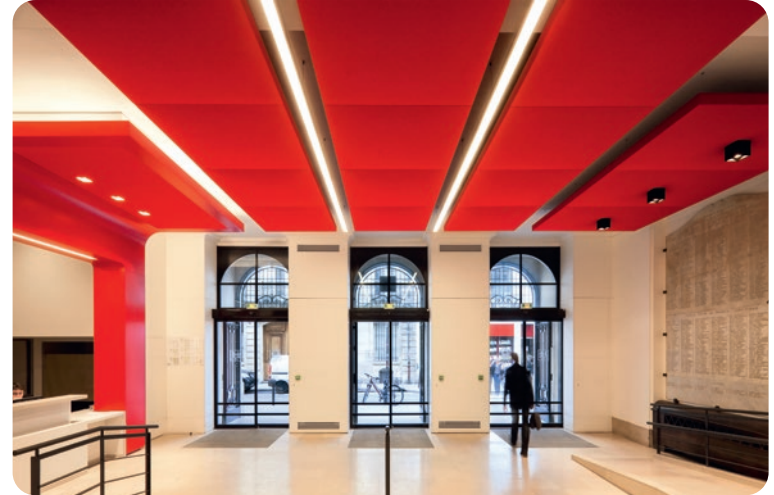
Maßarbeit. Paneele Stereo im Verbund abgehängt. Maßgeschneiderte Formate und eingebettete Deckenstrahler. Eingangshalle des Institut d'études politiques (Science Po), Paris. Gestaltung: Architekturbüro Sahuc & Katchoura, Claire Leroux.
