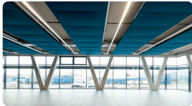
Composé de panneaux acoustiques Stereo disposés en nappe, le plafond Strato permet de traiter l'acoustique de larges espaces réverbérants. Cernay, Endress+Hauser Flowtec AG. Emergence architecture.
